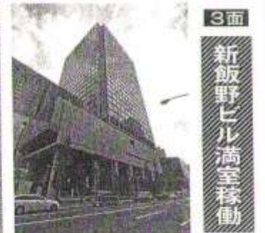
新飯野ビル満室稼働
